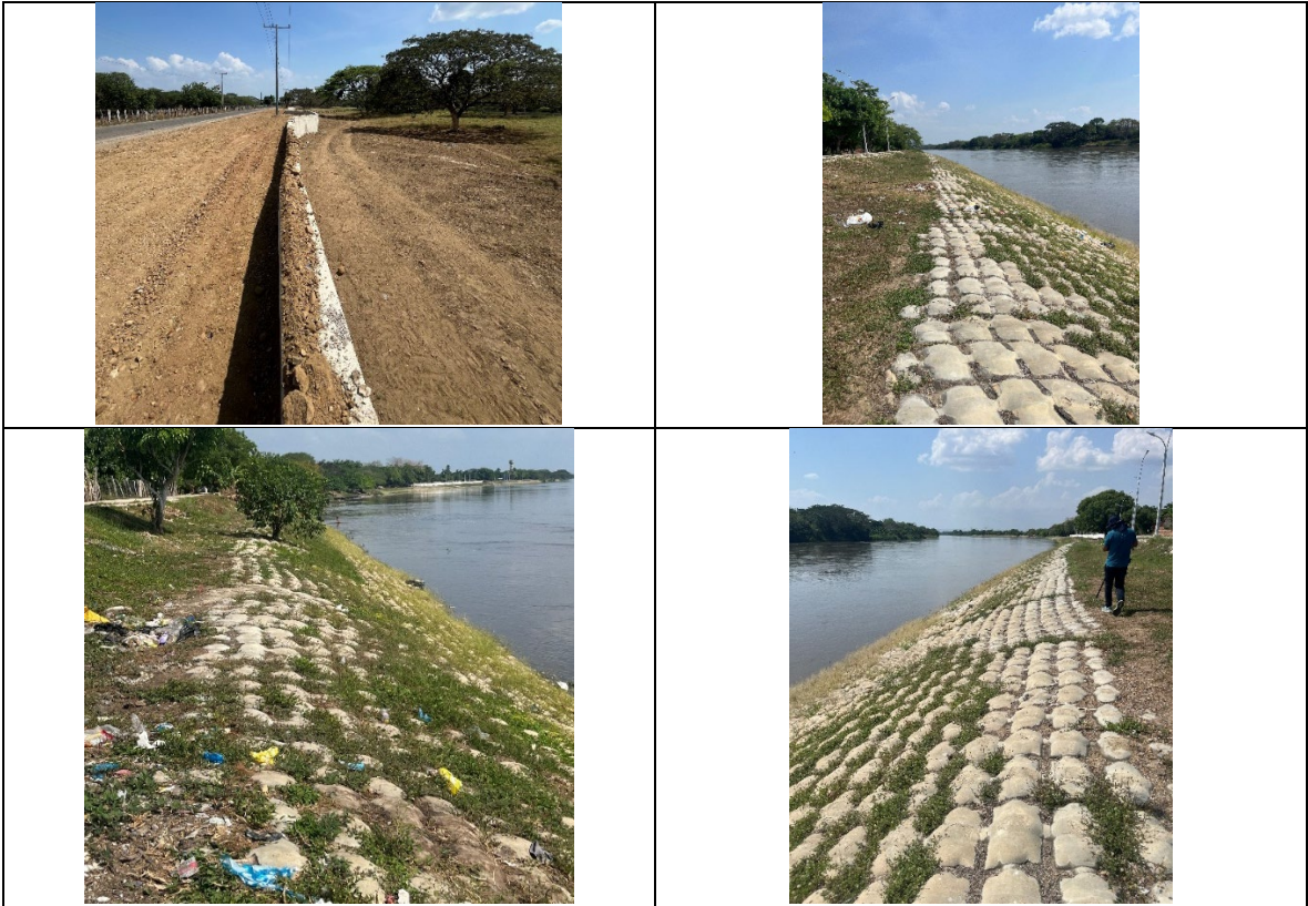
Figura 7: Infraestructura de contención contra riesgo de inundación Santa Lucía.
