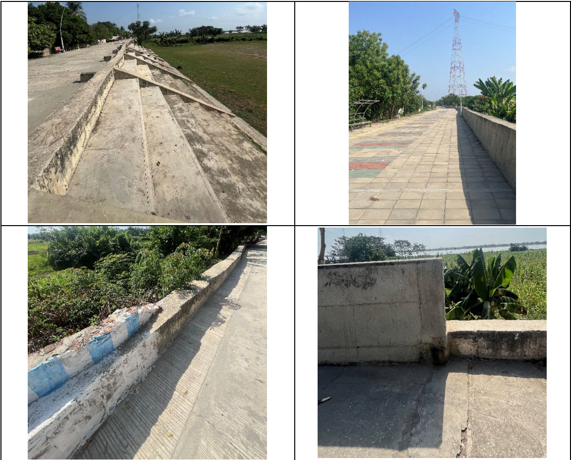
Figura 5: Infraestructura de contención contra riesgo de inundación Suan.
