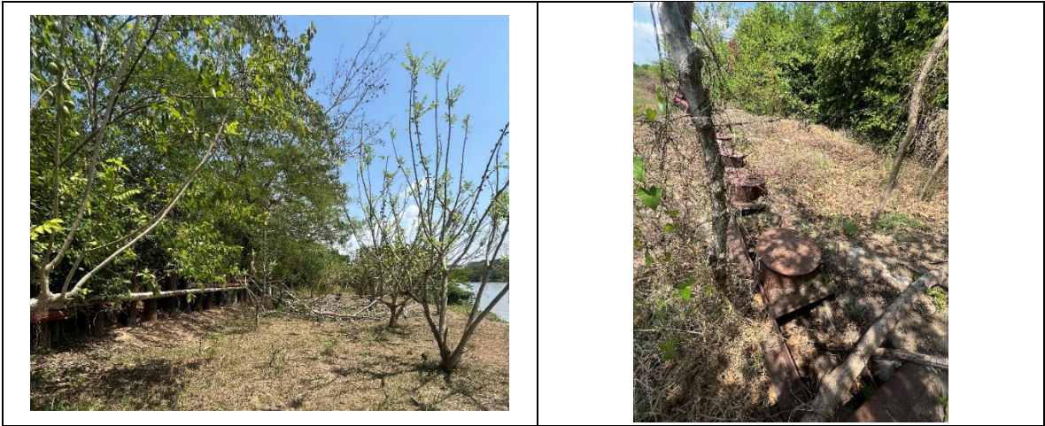
Figura 6: Infraestructura de contención contra riesgo de inundación Canal del Dique K3+300
