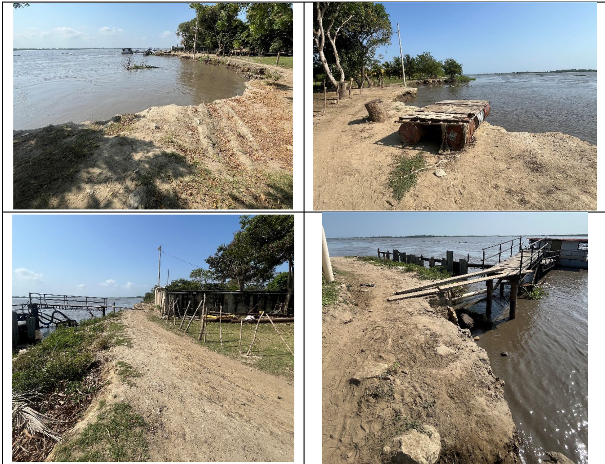
Figura 8: Infraestructura de contención contra riesgo de inundación Caimital (Malambo).
